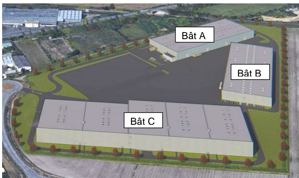
Vue aérienne du site Caillot Transports à Béthény -51 (source : dossier permis de construire).
